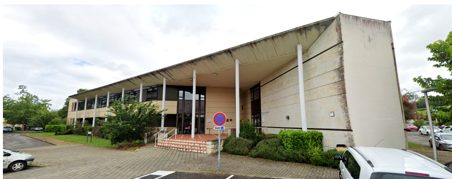
Bâtiment de la DOSIN ou est situé le pôle Développement
